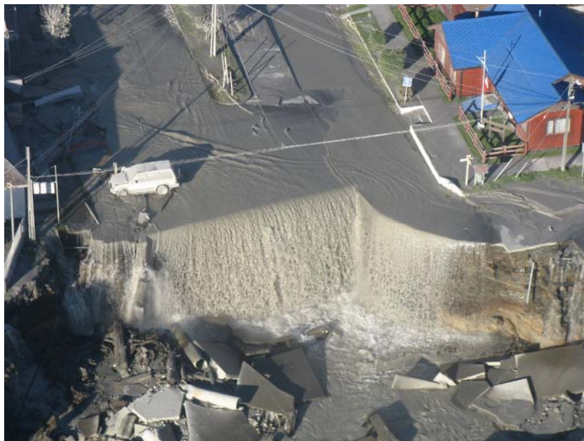
Fig. 5. Sector de la Gobernación Marítima el 26.05.08 y una “cascada” producida por uno de los brazos del río Chaitén en el extremo de una calle pavimentada.
