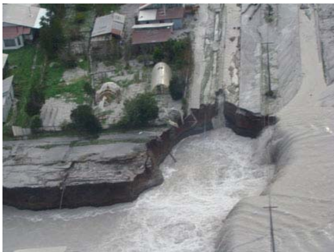
Fig. 2. Vista de la ciudad de Chaitén donde se aprecia profundas zanjas en los terraplenes a causa de los cursos de agua desbordados. La ciudad presenta ya un avanzado nivel de daños.
