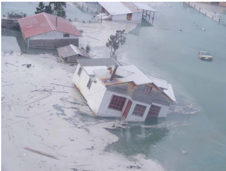
Figura 3. Sector ribereño del río Chaitén afectado por la corriente de lodo (lahar) y desborde del río debido al embancamiento del mismo.
